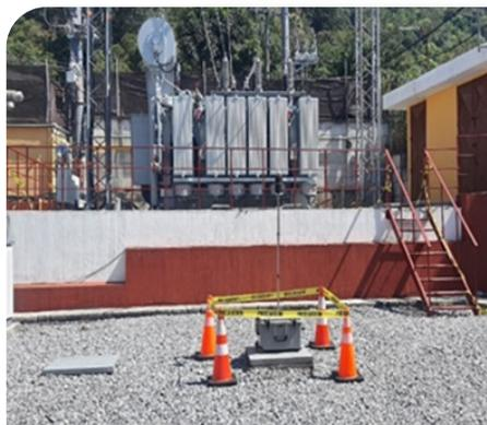
**Equipo instalado para la medición** de niveles de presión sonora (ruido) en subestaciones.
