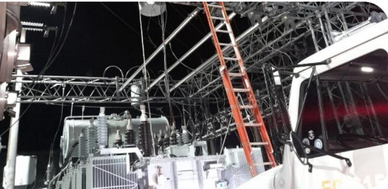
**Deschatarización de las subestaciones Santa Mónica y Centro.** Se trabajó en la deschatarización de las subestaciones Santa Mónica y Centro apoyando con tráiler con rastra, grúas, montacargas para la carga y traslado de la chatarra para las recicladoras en Escuintla, Mixco y zona 3, así como el reacomodo interno de postes de concreto. Estos trabajos se realizaron en conjunto y a solicitud de AMESA.
