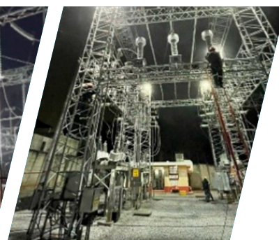
Ampliación subestación Ciudad Quetzal 69 KV
