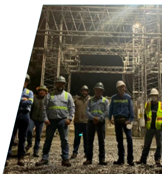
Ampliación subestación Papi Strachan 69 KV
