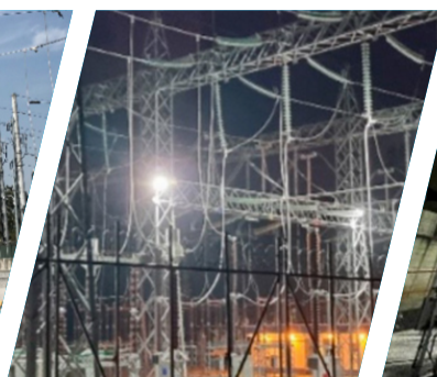
Ampliación subestación Guate Sur 230 KV
