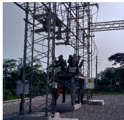
Mantenimiento a interruptor de potencia en subestaciones
