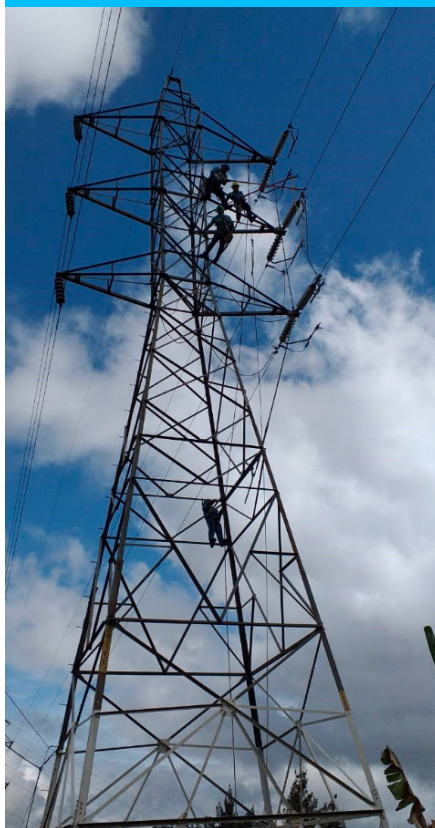
Mantenimiento a torre de línea de transmisión
