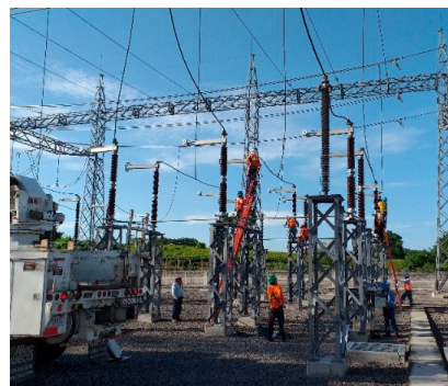
Mantenimiento general a subestaciones
