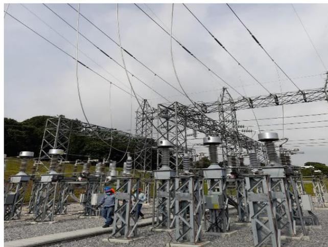
Se alcanzó el 90% de avance del proyecto de la ampliación subestación Guate-Sur, el cual consistente en red de tierras, un campo de 230 kV con montaje de un interruptor de potencia, un transformador de potencial, tres pararrayos, doble barra rígida, cuatro juegos de seccionadores, cableado y conexionado de equipos, en la parte de control instalación, alimentación de cableado y conexionado de cuatro tableros control y comunicación (PCYM) y servicios auxiliares (SSAA).
